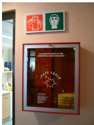
(Wandkasten mit Löschdecke)
